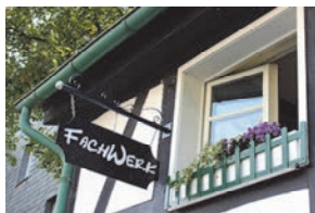
Das Fachwerk am Bachplatz.
