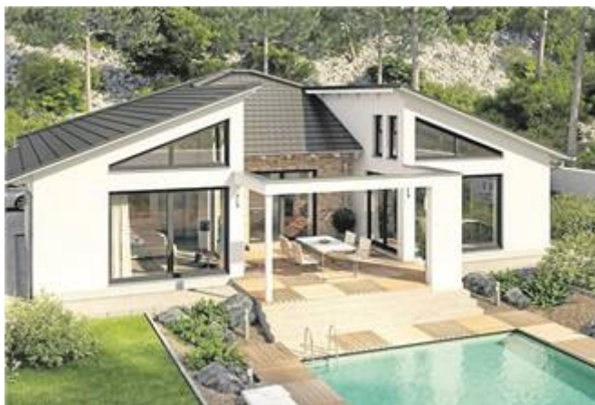
Hier ist die Terrasse das Zentrum des Hauses. Der Pool liegt eine Etage tiefer.
