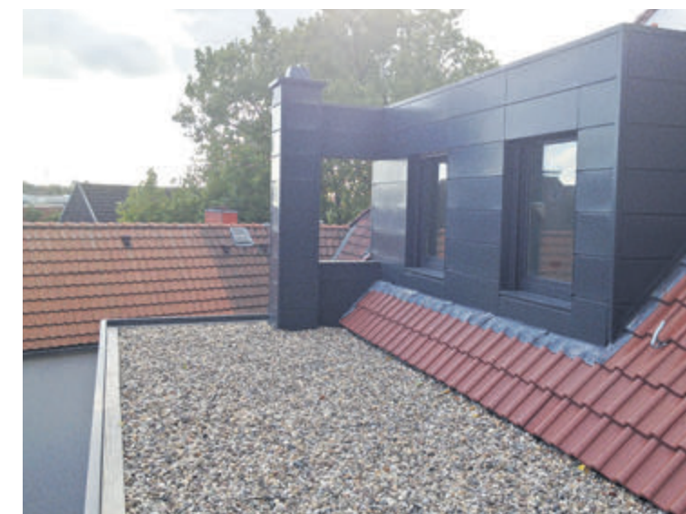
Auf Dachfenster hat sich Stefan Hericks spezialisiert. Diese Fassadenbekleidung einer Dachgaube mit Aluminium-Profilblechen hat Hericks in Coesfeld gebaut. Foto: pr
