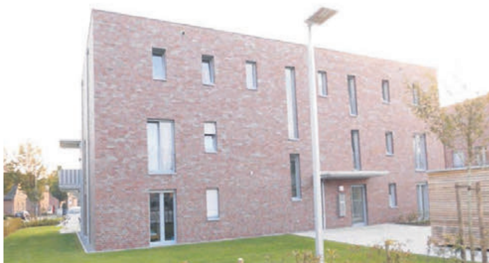
Am Dalweg in Dülmen hat WEMA über 500 Fenster eingebaut.
