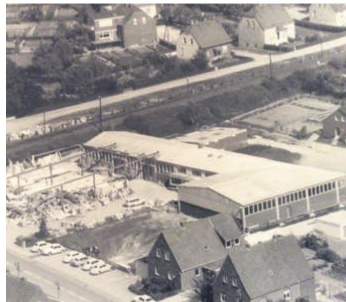
Das alte Firmengelände aus der Vogelperspektive.
