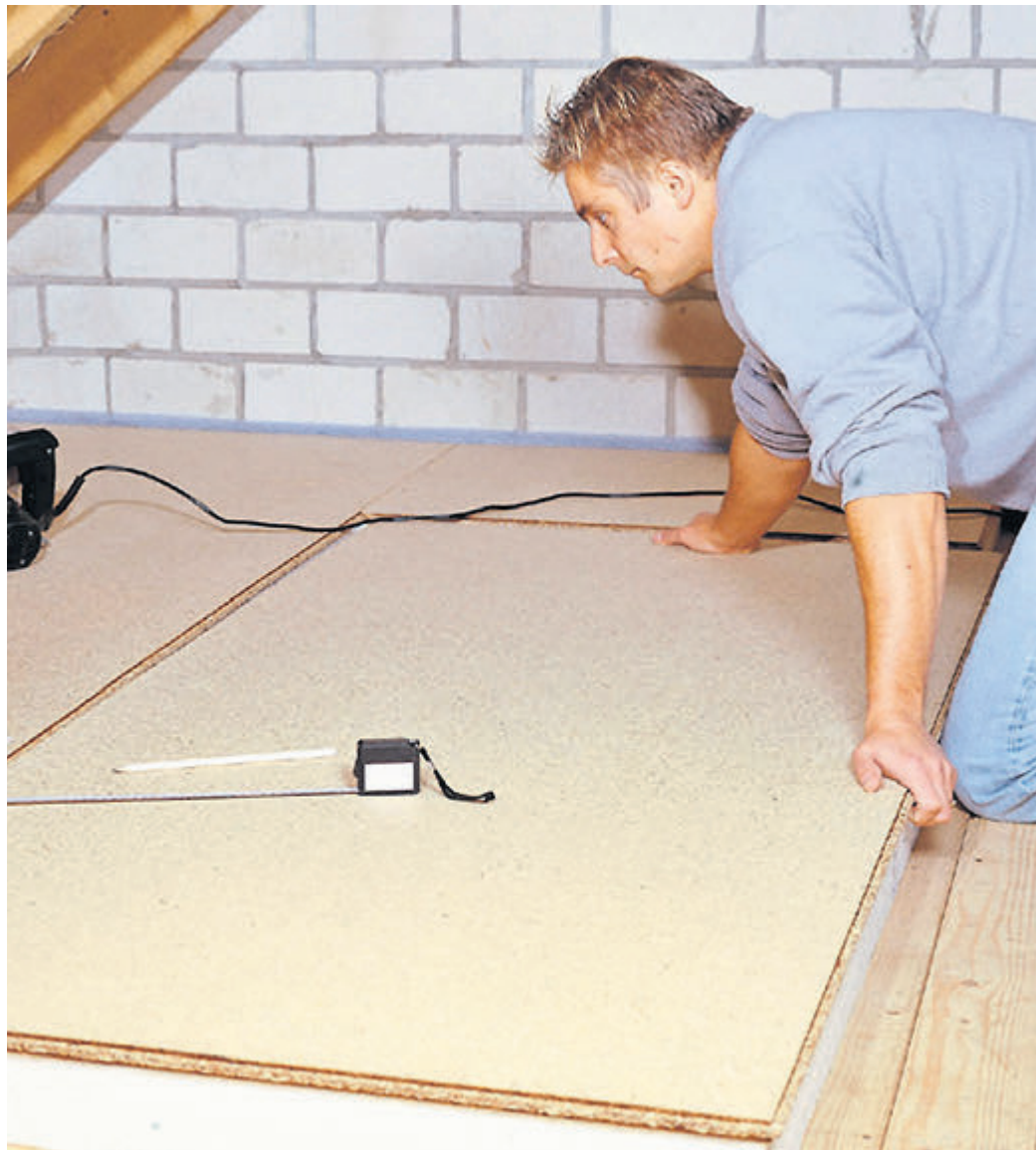
Dämmen lohnt sich nicht nur aufgrund der eingesparten Heizkosten, eine energetische Sanierung mit Styropor sorgt auch für ein gutes Wohngefühl. Foto: djd/IVH
