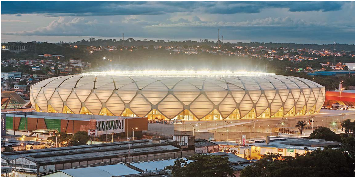
Die Dachverkleidung der Arena de Amazônia in Manaus soll rund 30 Jahre halten. Was hier noch beige aussieht, bleicht innerhalb von drei Monaten aus und wird schneeweiß.
