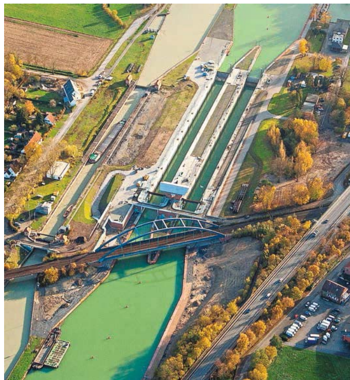
Die mehr als 100 Jahre alte Schleusenanlage am Kanal in Münster wurde erneuert und ausgebaut.
