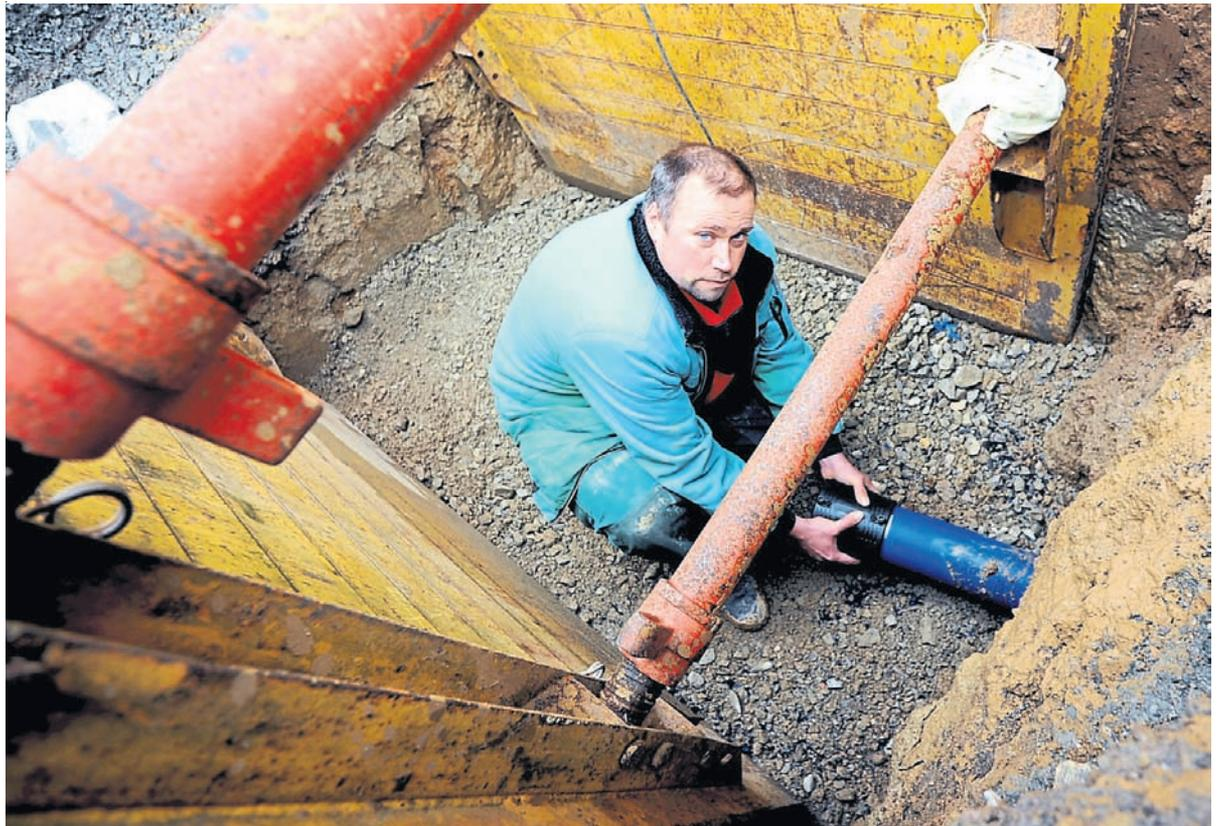
Im Spülbohrverfahren ist eine neue Wasserleitung verlegt worden. Tiefbauer Oliver Wittenborn (40) überprüft hier den Anschluss. Foto: Christia Geschke
