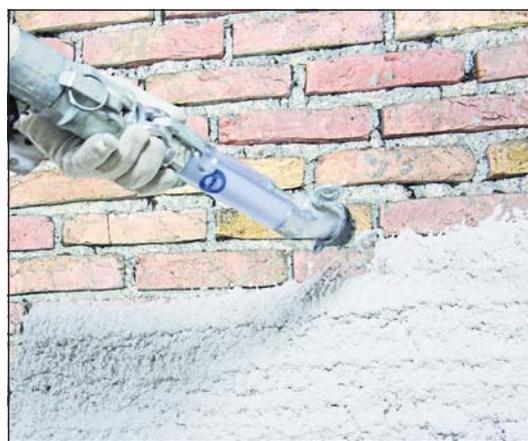
Um den Salzgehalt im Mauerwerk zu reduzieren, bieten sich Sanierputze an.
