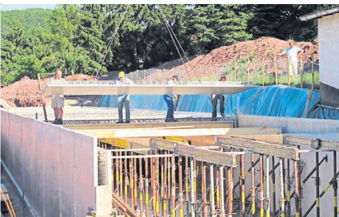
Ein Blick zurück: Das Foto vom Juli 2010 zeigt die Baustelle beim Einbau der Wände und Decken des neuen Schießstandes.
