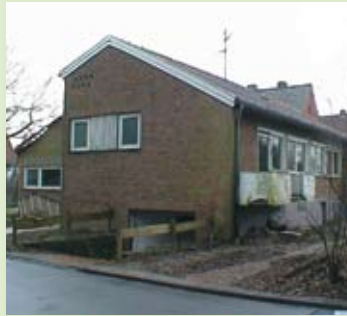
Gebäude vor der Sanierung
