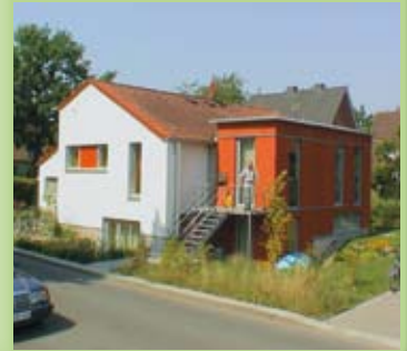
Gebäude nach der Sanierung
