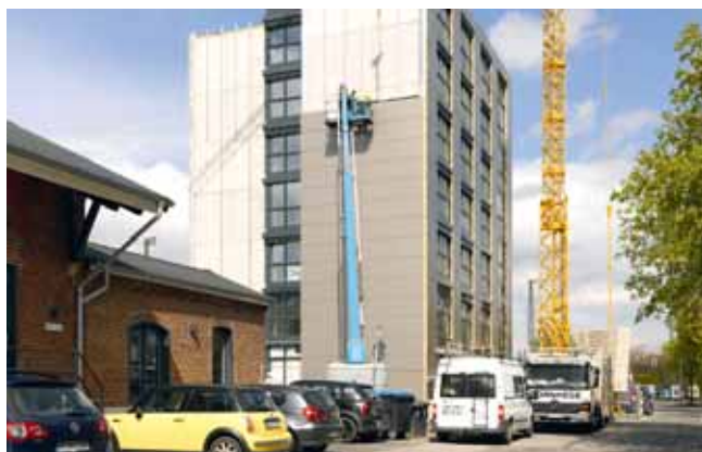
Eine neue, schicke Büroadresse wird gebaut: das businessdock 2.0.
