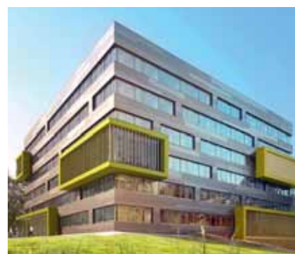
Die Geowissenschaften der Uni erhalten ein hochmodernes Gebäude.
