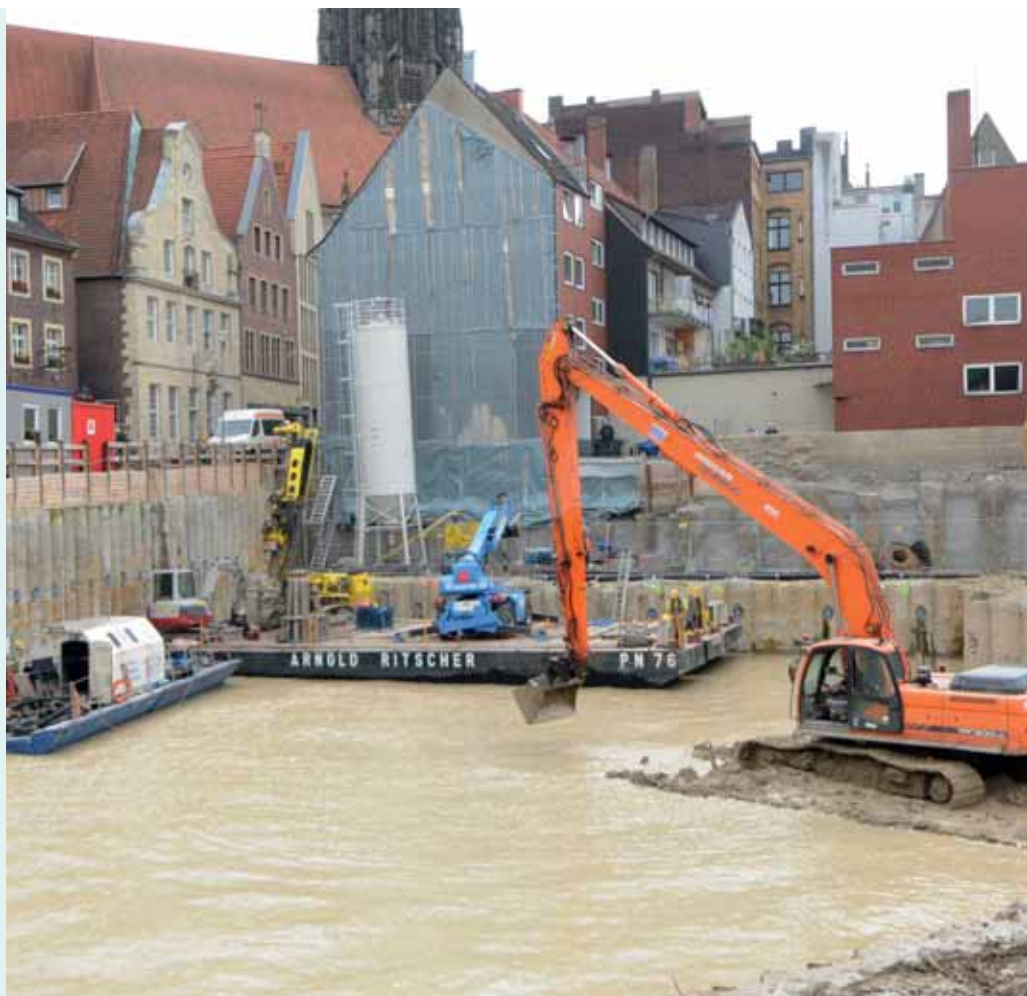
Die Baugrube am „Alter Fischmarkt“ füllt sich nach und nach mit Grundwasser, bis ein See zu sehen ist.
