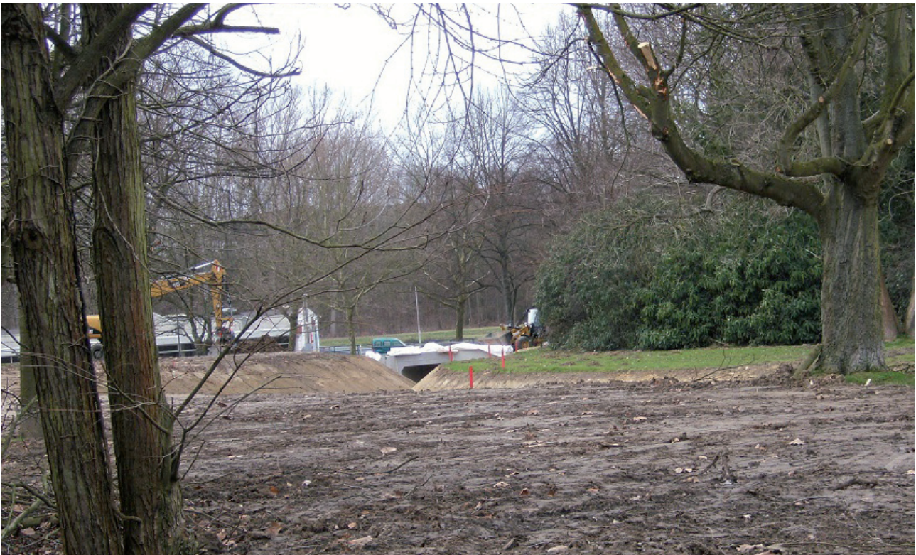
Abbildung 10: Bauarbeiten Oespeler Bach (Gewässer der Emscher-genossenschaft), Stadtpark Marten
