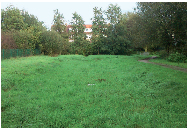
Abbildung 23: Retentionsmulde in einer öffentlichen Grünanlage
