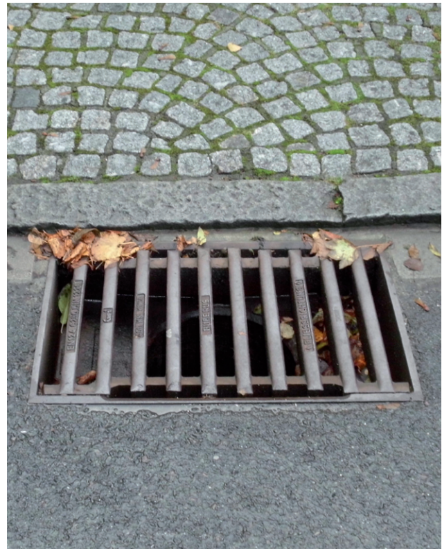
Abbildung 24: Überbreiter Sinkkasten An der Margaretenkapelle
