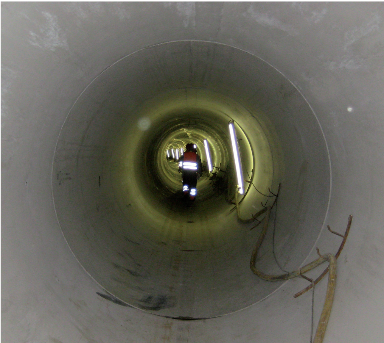
Abbildung 27: Regenrückhaltekanal Tremonia am 09.02.2009
