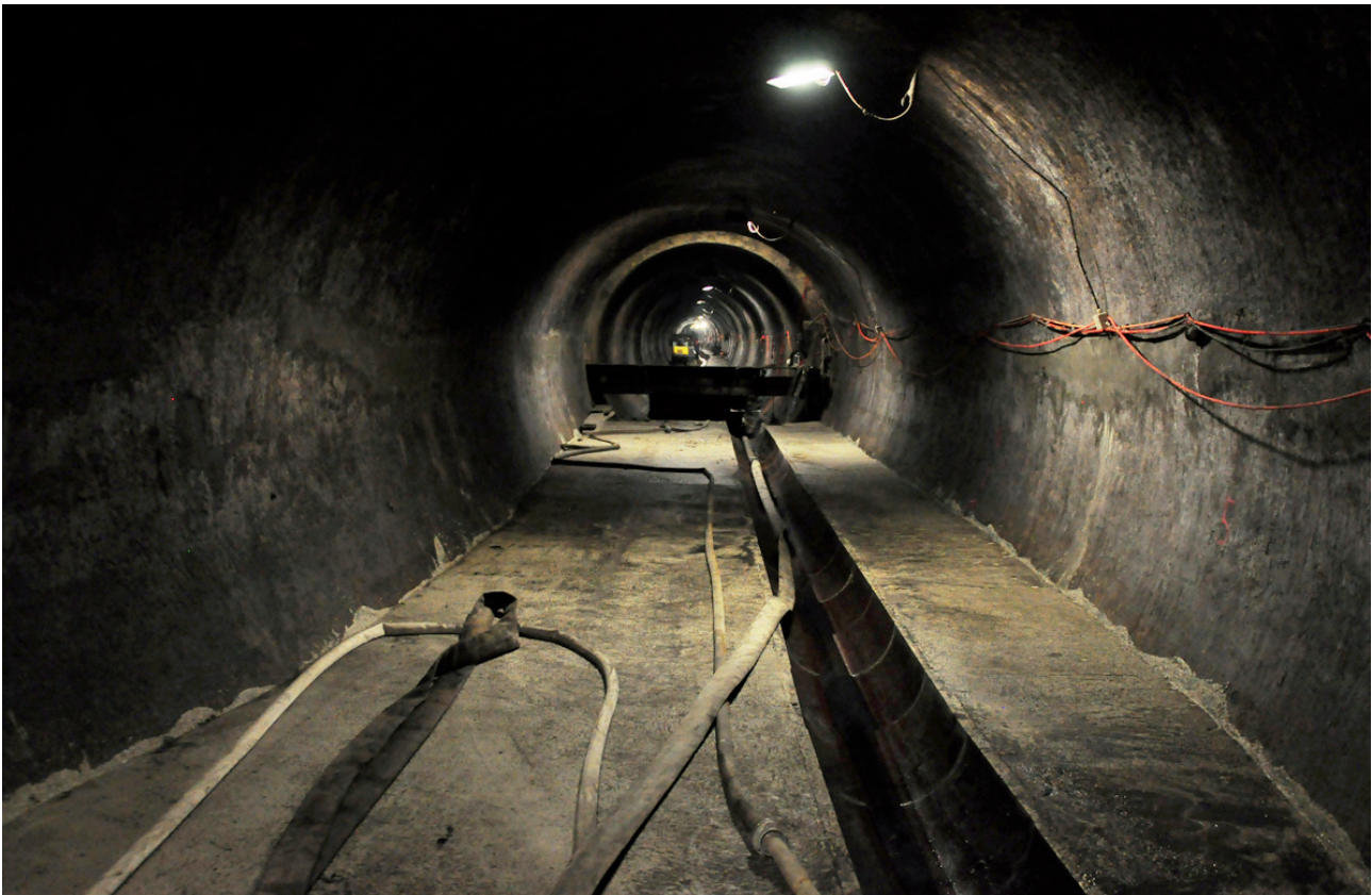
Abbildung 28: Einbau der Trockenwetterrinne
