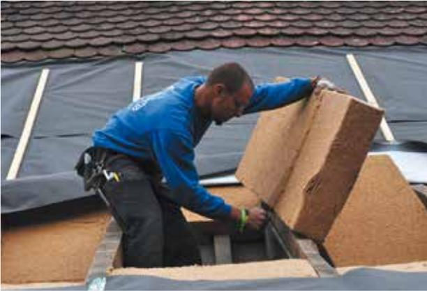
Abb. 45\_\_Holzweichfaserplatten werden für die Zwischensparrendämmung passend geschnitten, sie sorgen für guten sommerlichen Hitzeschutz; Quelle: Gutex
