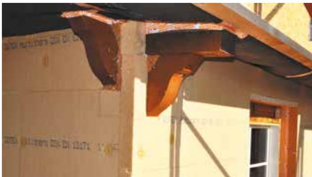
Abb. 44\_\_Feste Holzweichfaserplatte als Außendämmung einer hinterlüfteten Fassade, Quelle: Gutex
