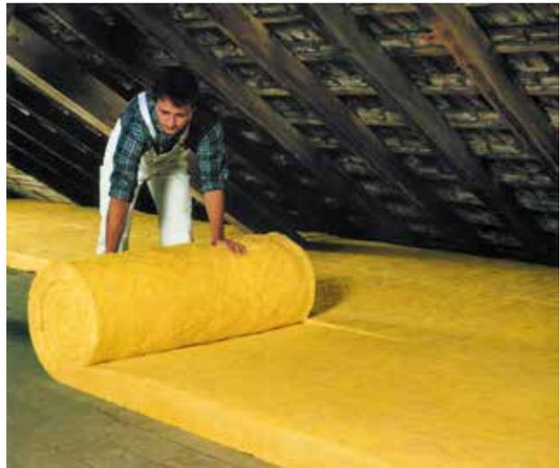
Abb. 53\_Dämmung der obersten Geschossdecke mit Glaswolle-Matten.
