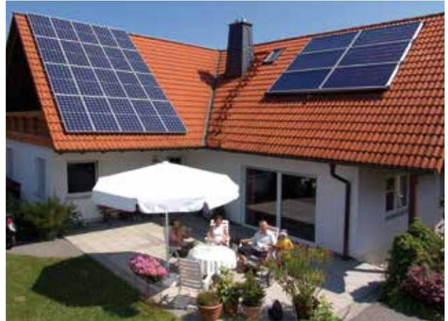
Abb. 72\_\_PV-Module und thermische Kollektoren auf dem Dach, die mit dem Kombispeicher das Hybridsystem bilden. Quelle: Wagner & Co
