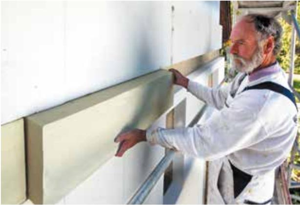
Abb. 53\_\_PUR-Hartschaumplatten als Brandschutzriegel in der Polystyrol-Dämmung. Quelle: Puren
