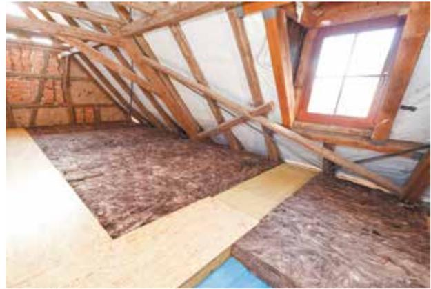
Abb. 54\_\_Weiche und feste Mineralwolle-Matten für unterschiedliche Belastung. Quelle: FMI
