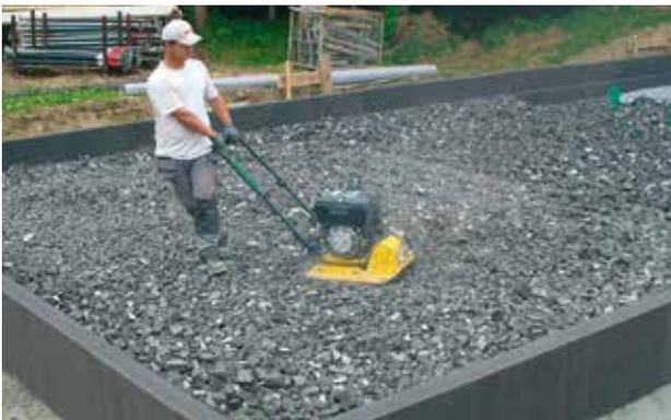
Abb. 51\_\_Glasschaumschotter wird verdichtet als Träger der Bodenplatte für einen Kindergarten. Quelle: Glapor
