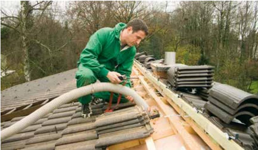
Abb. 48\_Zellulose zur Hohlraumdämmung muss vom Fachmann eingeblasen werden. Quelle: Steico
