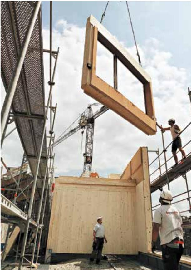
Abb. 46\_\_Im Werk mit Holzweichfaserdämmung vorbereitete Außenwände werden auf der Baustelle zusammengefügt. Quelle: Pavatex
