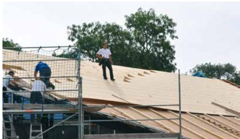
Abb. 47\_\_Holzfaserdämmstoffe im Dach für guten sommerlichen Hitzeschutz. Quelle: Gutex
