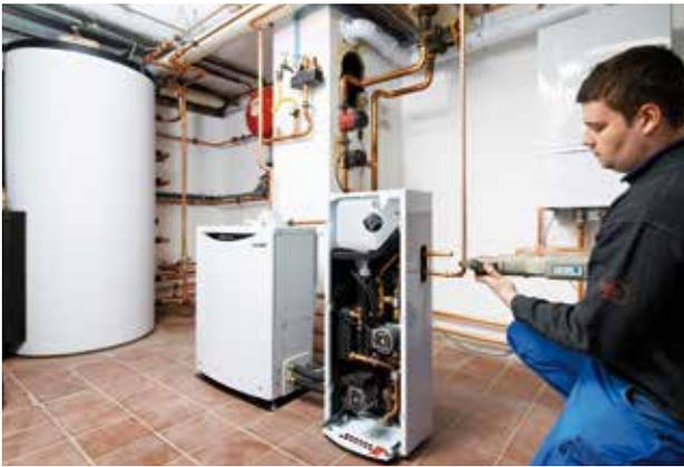
Abb. 61\_Mikro-BHKW – Vaillant
