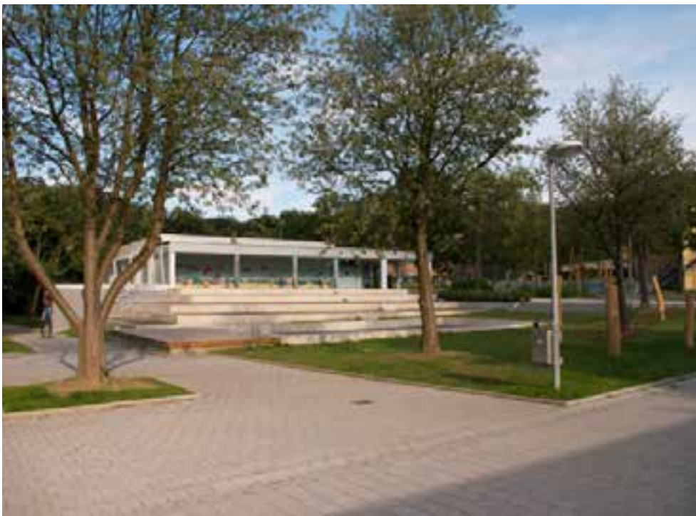
Die Bucht (ehem. Lehrschwimmbecken)
