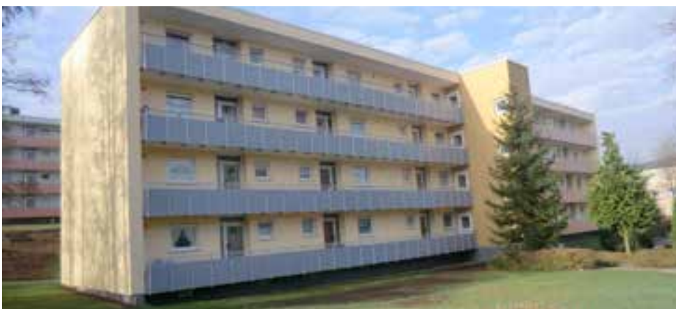
Gebäudebestand Eschenstraße /Moosfelder Ring
