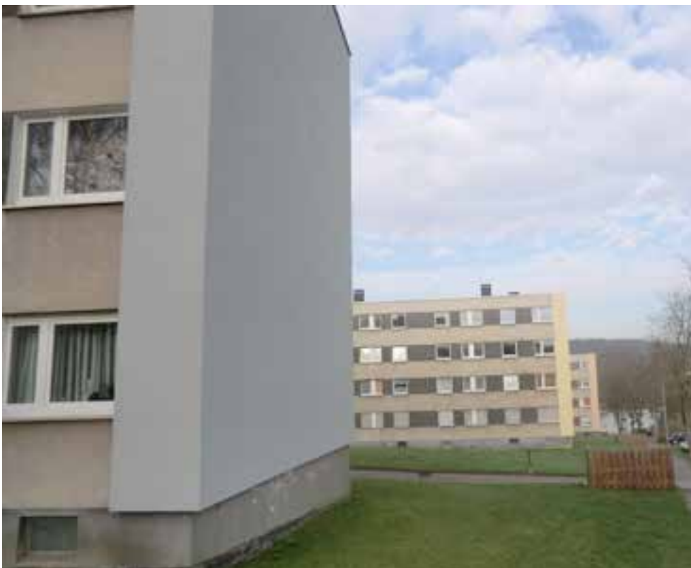
Eindrücke der Gebäudebestände
