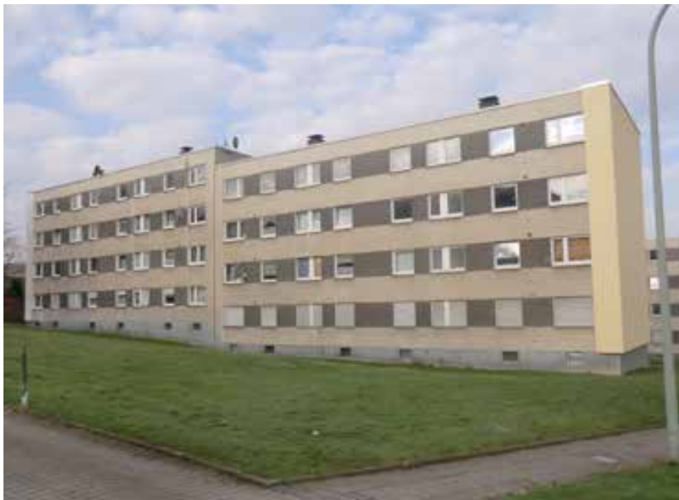
Südlicher Gebäudebestand Eschenstraße
