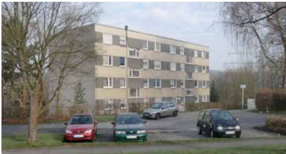
Westlicher bzw. nördlicher Gebäudebestand Ahornstraße
