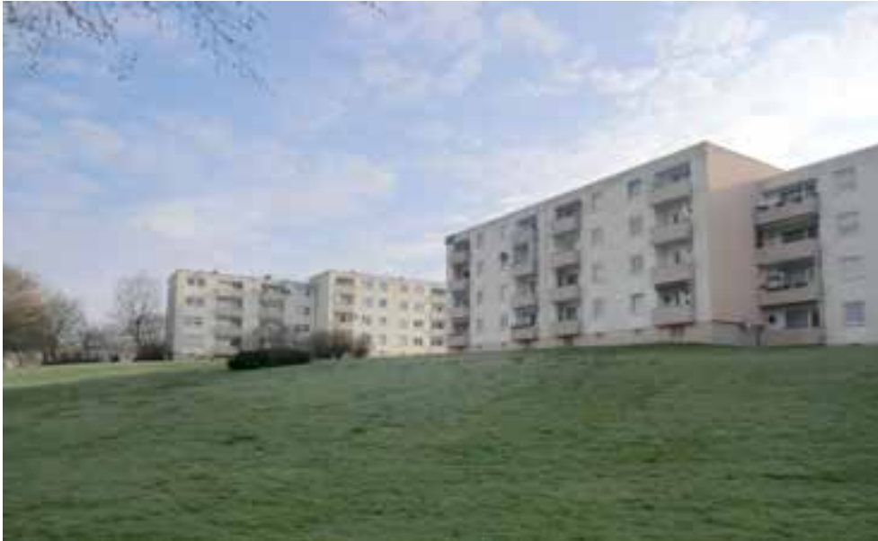
Gebäudebestand zwischen Ahornstraße und Moosfelder Ring
