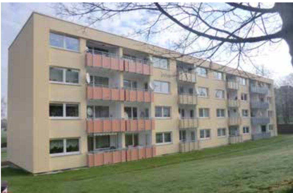
Sanierung des Gebäudebestandes an der Eschenstraße
