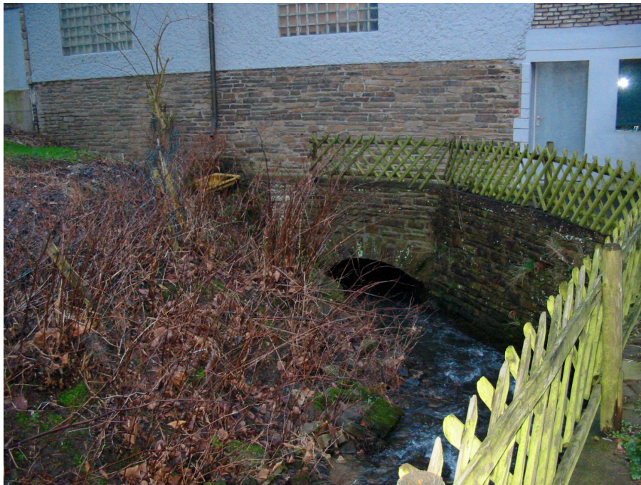
Foto 1: alte Gewölbedurchlässe für den Herdecker Bach am Rande des nördlichen Siedlungskernes
