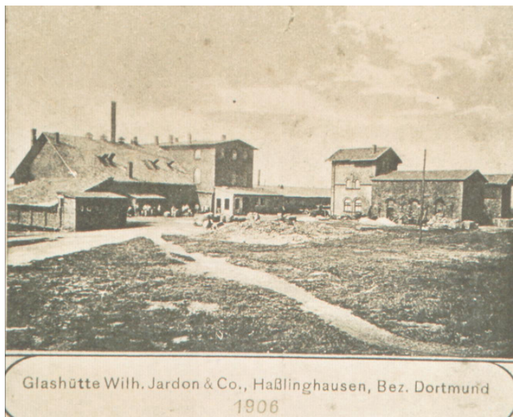
Gebäude der Haßlinghauser Hütte, später Glashütte, 1906
