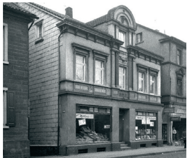
Abbildung 14: Historisches Foto von Schaufenstern mit Oberlichtern in der Kaiserstraße
