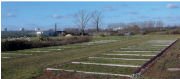
Abbildung 19: Stellplatzanlagen mit Schotterrasen
