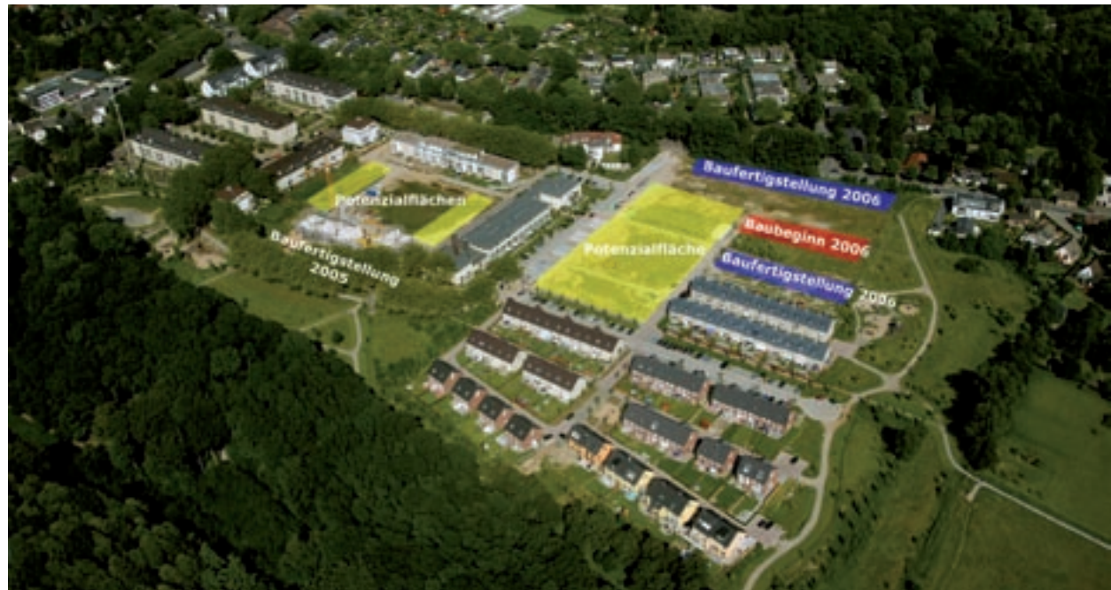
Wohnpark Witthausbusch (Luftschrägbild 2003)
