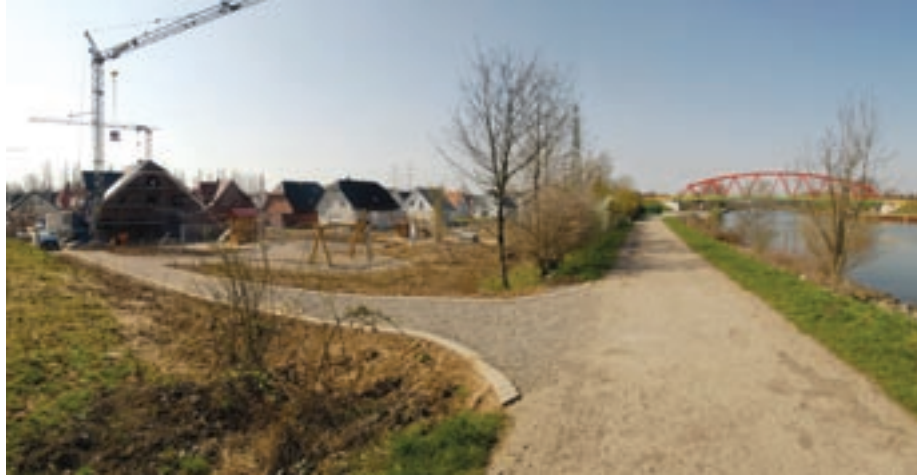
Das Wohngebiet auf „Unser Fritz“ in der Bauphase (2005)
