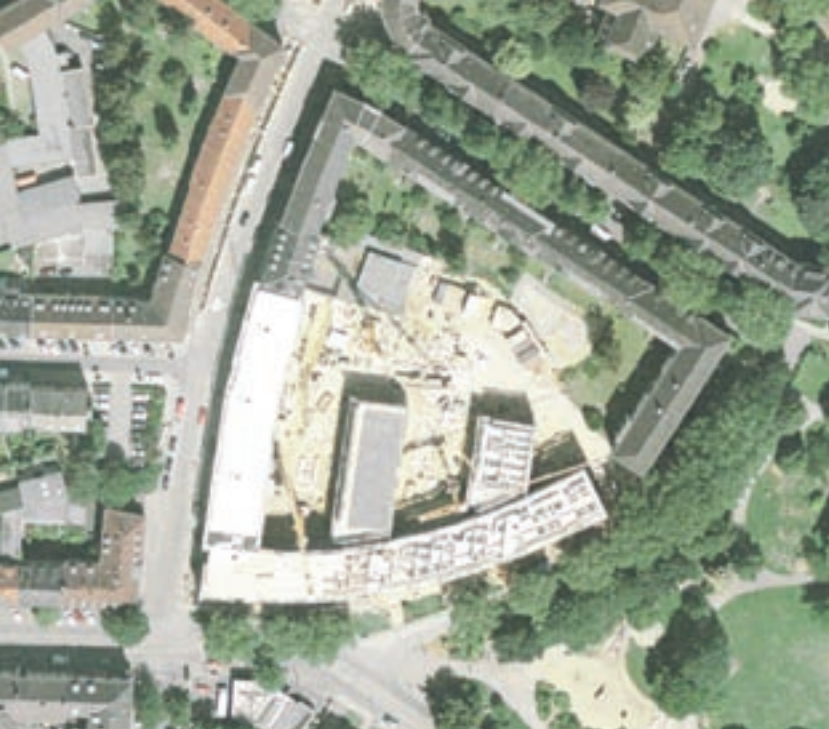
Riehlpark während der Umbauphase (Luftbild)
