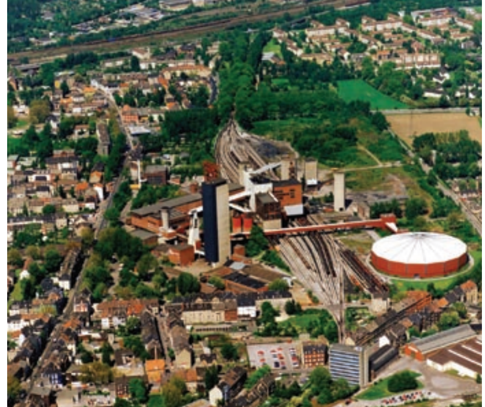
Schachanlage Consolidation 3/4/9 im Jahr 1992
