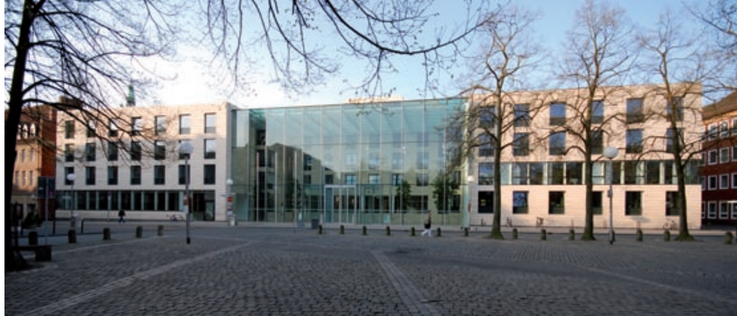
Architektonisch und städtebaulich hochwertiger Neubau, der sich optimal in die vorhandenen Strukturen einpasst und dennoch Akzente setzt
