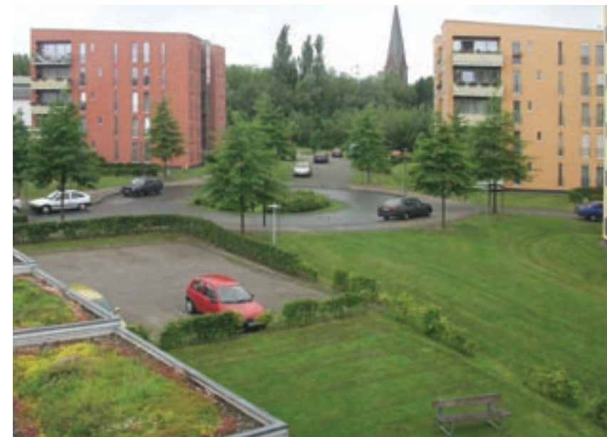
Innovativ: Ökologische Baustandards im Sozialen Wohnungsbau der Neuen Mitte Röhlinghausen
