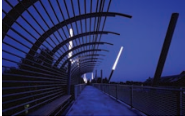
Stegbrücke in der Innenstadt West
