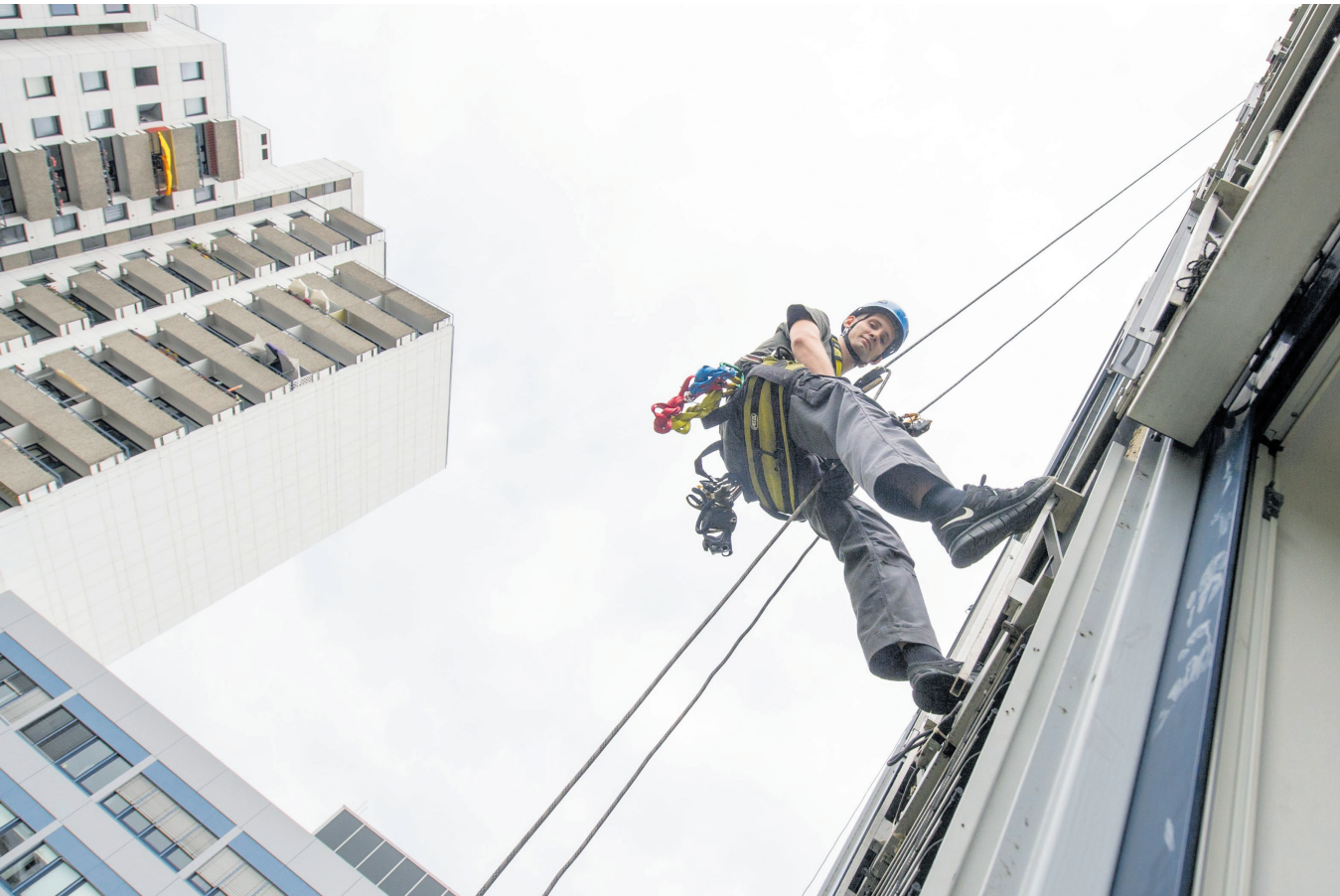
Nichts für schwache Nerven: Marlon Simon ist Industriekletterer. Er repariert zum Beispiel Regenrinnen an sehr hohen Gebäuden, an die man mit Leitern und Gerüsten nicht herankommt. FOTO DPA
