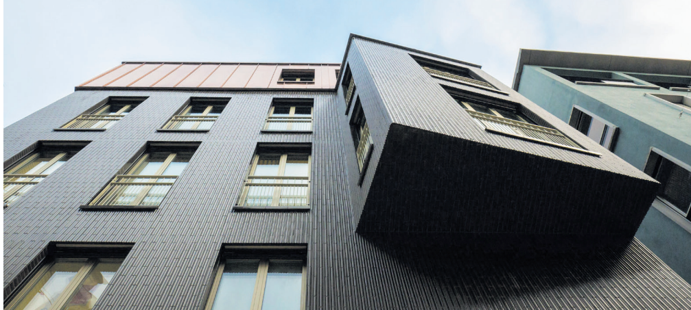
Dieses Haus trägt eine Hülle aus Keramik. Grundsätzlich ist bei der Wahl der Fassadenbekleidung auch der Wetterschutz und eine effiziente Wärmedämmung wichtig. FOTO AGROP BUCHTAL/DPA
