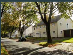
Häuser in der Engländeriedlung. Foto: Privat
