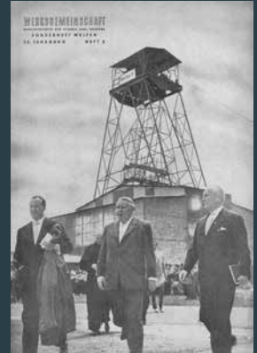
Auf dem Weg zum ersten Spatenstich auf der Zeche Wulfen: Ludwig Erhard (Mitte). Quelle: „Werksgemeinschaft – Werkzeitschrift der Stinnes-Betriebe“, Sonderheft Wulfen, 1958
