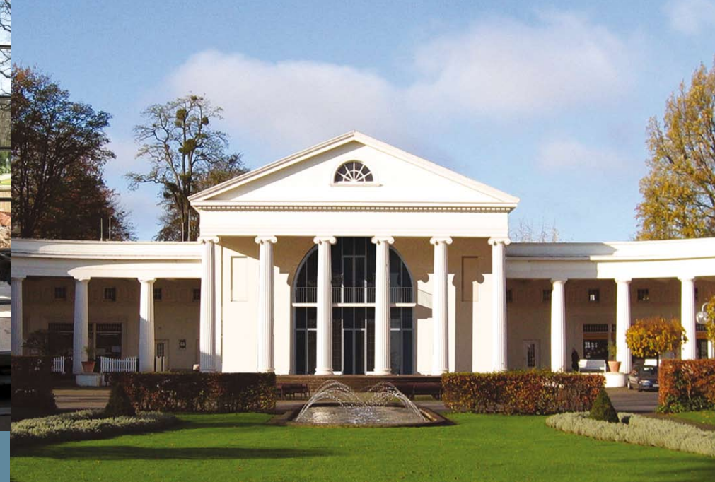
Die „neue“ Wandelhalle - Ergebnis einer sensiblen Restaurierung.
