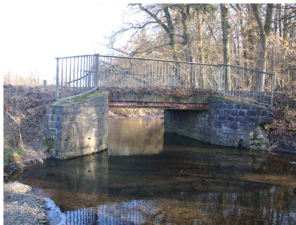
Foto 8: Unterquerung des "Retringer Wegs"
