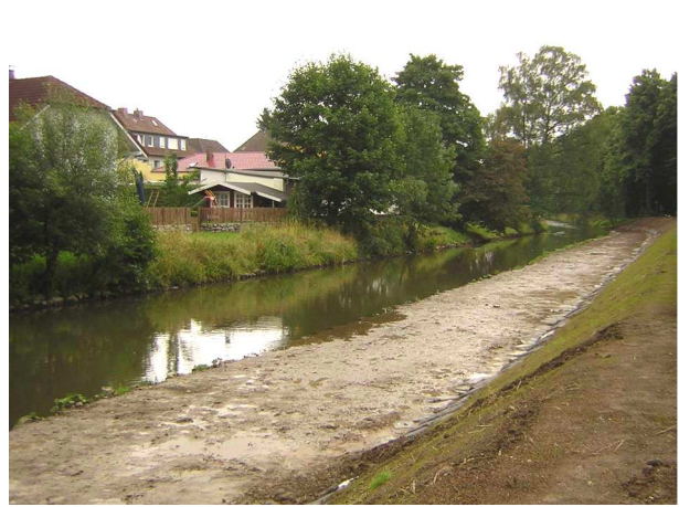
Foto 52: Bereich Daimlerstraße nach Aufweitung 2008
