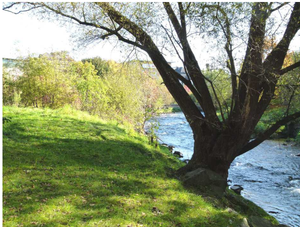
Foto 61: Ufer unterhalb Märkische Straße
