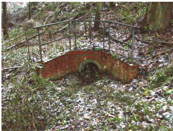
Foto 77: Verrohrungsbeginn Wietholz (V-Rü-8)
