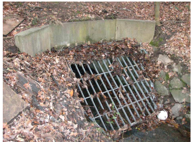
Foto 76: Durchlass Pfarrer-Wiggen-Straße (VR-Pl-1)
