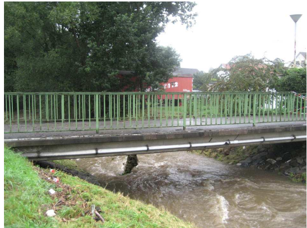
Foto 17: Fußgängerbrücke Walzweg / Fischkuhle
