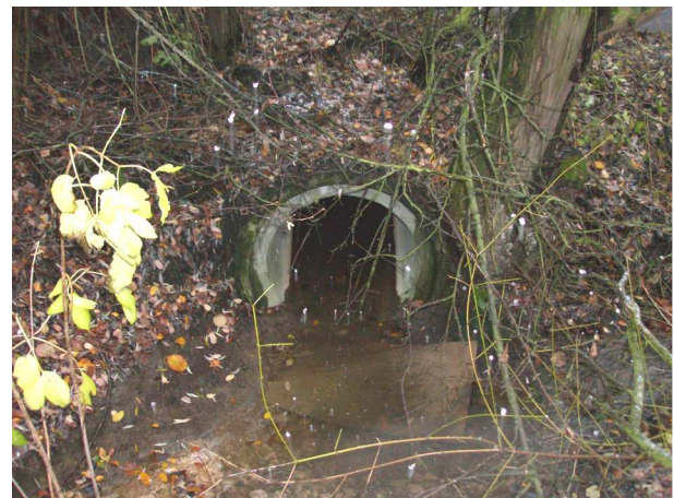
Foto 78: Verrohrungsbeginn Provinzialstraße (V-Rü-7)
