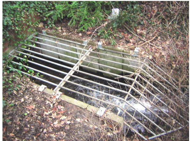
Foto 89: Durchlassgitter "Zum Mühlenteich"
