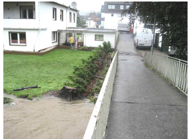
Foto 46: Fußgängerbrücke rechts August 2007
