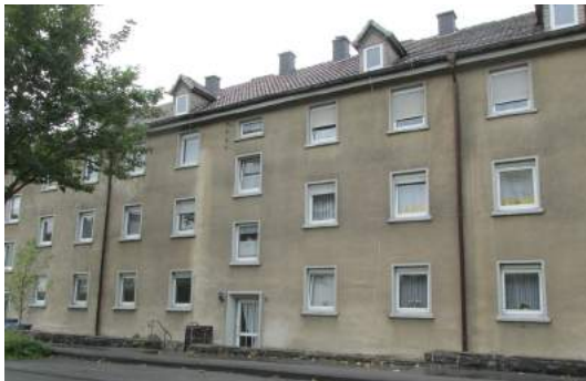
ABB 024 Sanierungsbedarf an der Ringstraße Quelle: SSR
