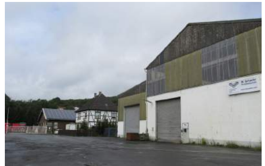
ABB 045 Gewerbegebiet „Zu den Werkstätten“
