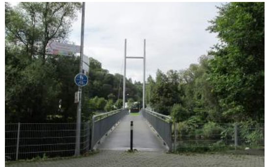
ABB 054 Neue Fuß- und Radwegebrücke
