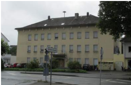
ABB 032 Sanierungsbedarf an Clemens-August-Str. Quelle: SSR
