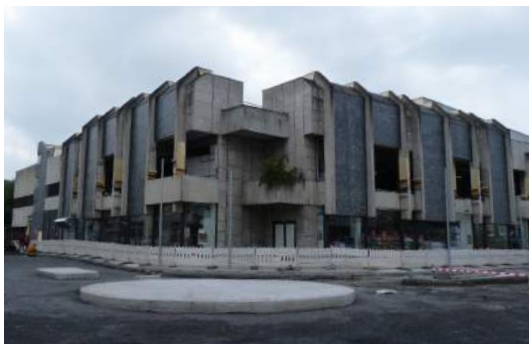
ABB 031 Sanierungsarbeiten am Brückencenter Quelle: SSR
