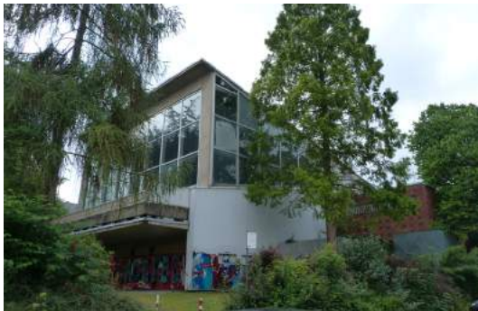
ABB 060 Leerstehendes Hallenbad Quelle: SSR
