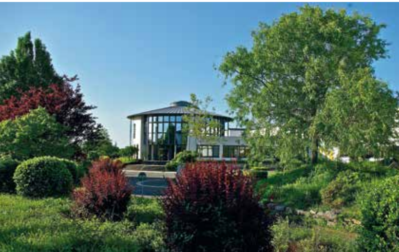
Industriepark Höingen, Firma Franz Brinkmann GmbH
