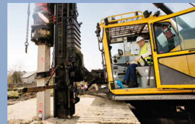
Dr. Andreas Hettich setzte am 6. April den ersten Gründungspfehl für die Erweiterung der Fertigung von Auszugführungen. Foto: Hettich
