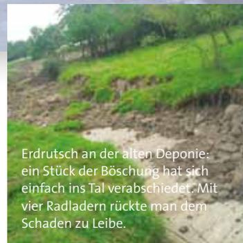
Erdrutsch an der alten Deponie: ein Stück der Böschung hat sich einfach ins Tal verabschiedet. Mit vier Radladern rückte man dem Schaden zu Leibe.
