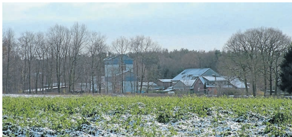
Blick vom Ahlinteler Esch auf das Wasserwerk Ahlintel.
