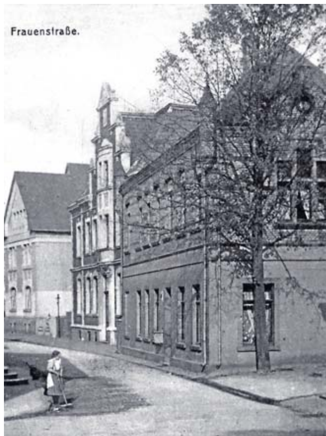
1878 kaufte die Gemeinde dieses Gebäude von der Firma Hollefeld & Söhne. Dahinter das Amtshaus von 1906.
