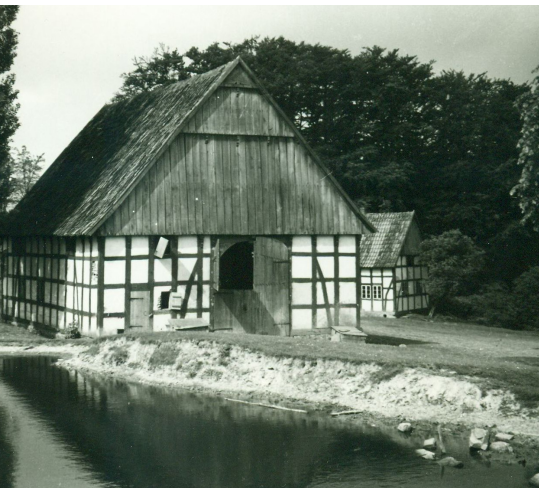
Scheune des Hofes Meyer Kerkhoff (KAH, Slg. Fenske)
