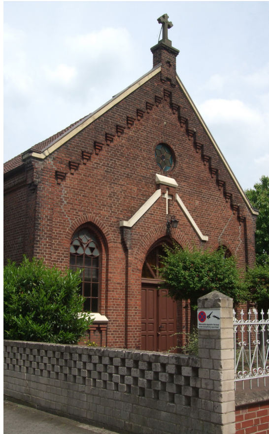
Die kath.-apostolische Kirche an der Renntormauerstraße 2008 (Foto: FM Kiel-Steinkamp, NW)
