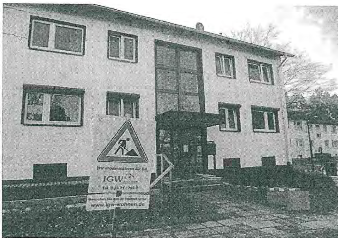
Sanierung an der „Niddastraße“
