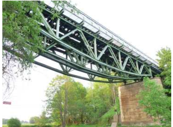
Die Eisenbahnbrücke von 1910 als Fischbauchträgerbrücke gebaut
