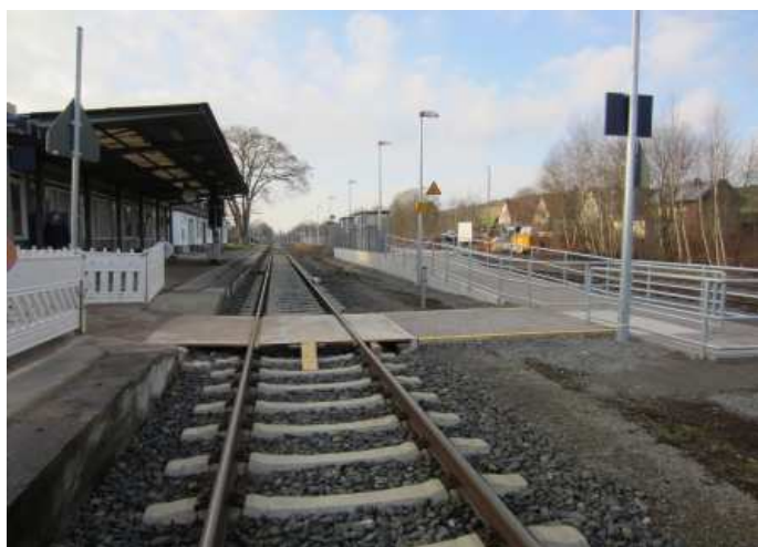
Übergang zum bereits erhöhten Bahnsteig 2
