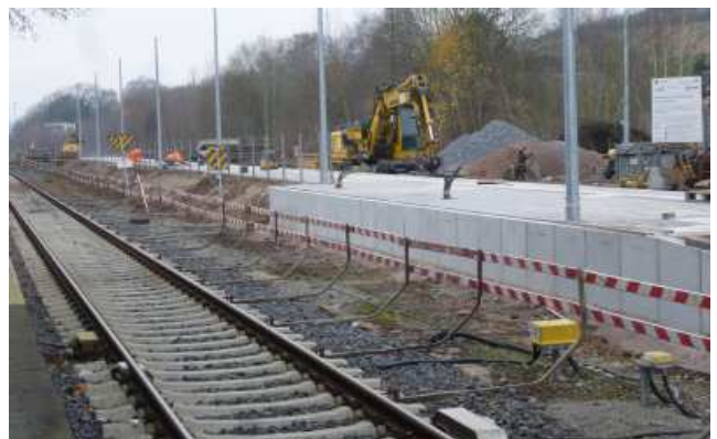
Das Gleis 2 ist verlegt und der Bahnsteig fast fertig
