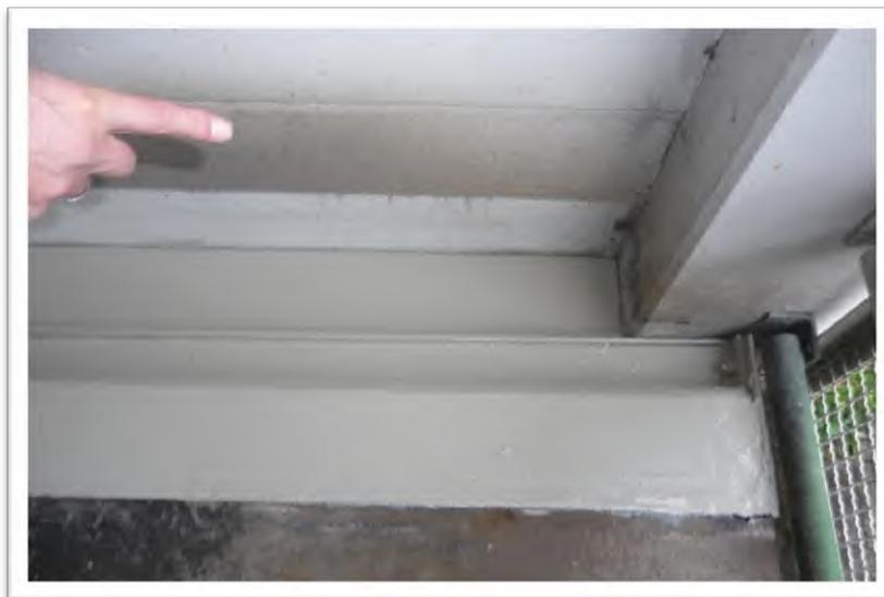
Rinne nach Durchführung der Korrosionsschutzarbeiten
