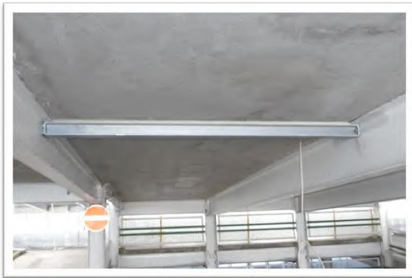
Im Bereich des Plattenstoßes eingebauter zusätzlicher Stahlträger
