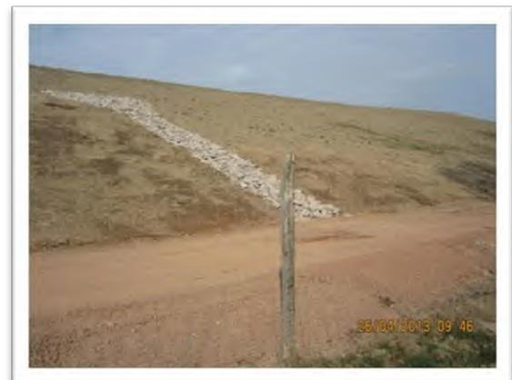
Der Beginn des Lärmschutzwalls ist mit Bodenmassen aus dem Gewerbegebiet teilweise errichtet worden
