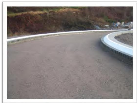
Die Frostschuttschicht ist eingebaut. Der KVP ist fertig für die Asphaltierung
