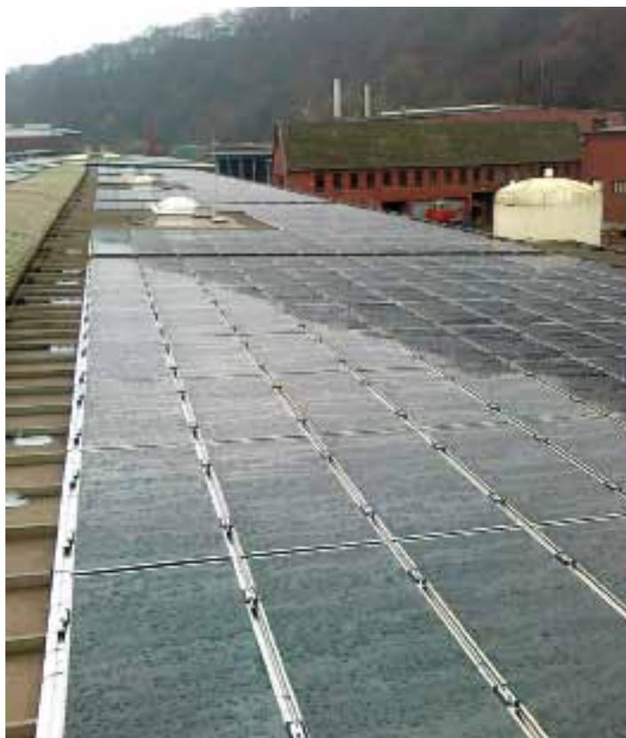
Das Kraftwerk besteht aus 3142 Dünnschicht-Solarmodulen.
