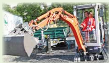
Baggern bei Höpken
