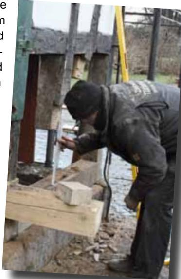
Feuchtigkeit hat die Balken so geschädigt, dass die unteren Teile erneuert werden müssen.
