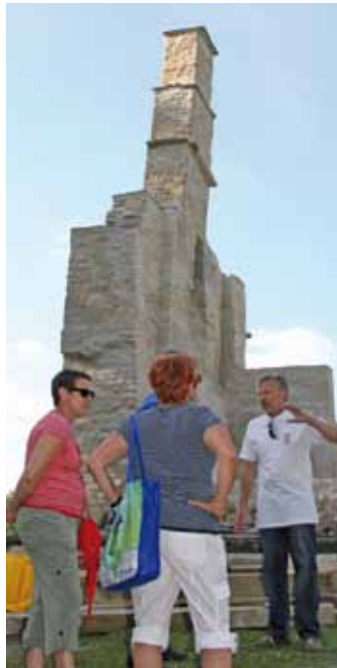
So reckt sich der sanierte „Zeigefinger“ des sagenumwobenen Zwerges Goldemar mah-nend gen Himmel (lks.): Es werden dringend noch Spon-soren gesucht, die das Defizit auszugleichen helfen.
