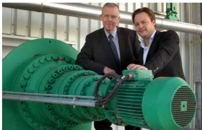
Der neue AHE-Geschäftsführer Jürgen Ephan (l.) und Prokurist Johannes Einig an der Biogasanlage im Bebbelsdorf Foto: Zabka
