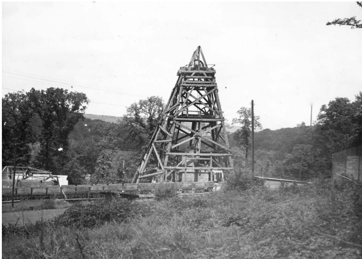
Abb. 19: Teufgerüst des Franziska-Schachtes 2 der Grube Camphausen bei Saarbrücken, errichtet durch die Maschinenfabrik und Unternehmung für bergbauliche Arbeiten Frölich & Klüpfel, undatiert (montan.dok/BBA 273/12)
