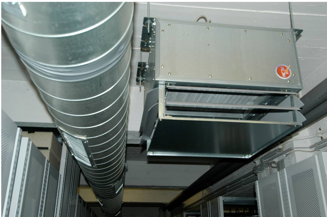
Abb. 1: Deckenradiator und Entlüftungseinrichtung zur Klimatisierung im zentralen Außenmagazin des Bergbau-Archivs
