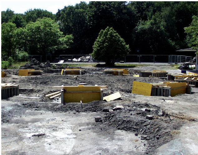
Frisch eingeschaltete Betonfundamente
