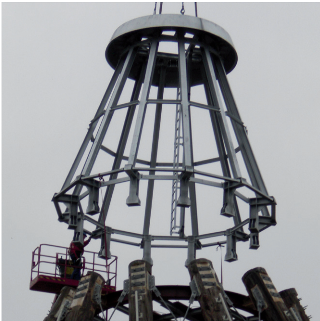
Montage mittlere Zeltspitze
