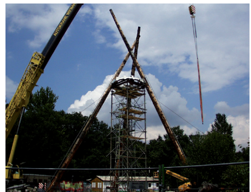
3-D Gerüst zur Stabilisierung
