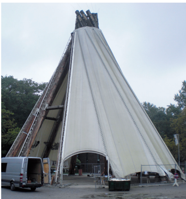
Demontage Alte Membrane
