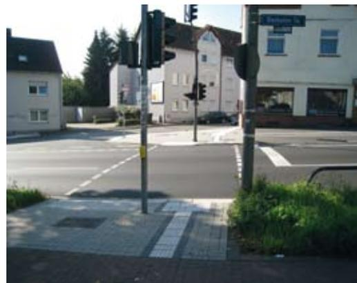
*Barrierefreie Querung mit Signalanlage*
