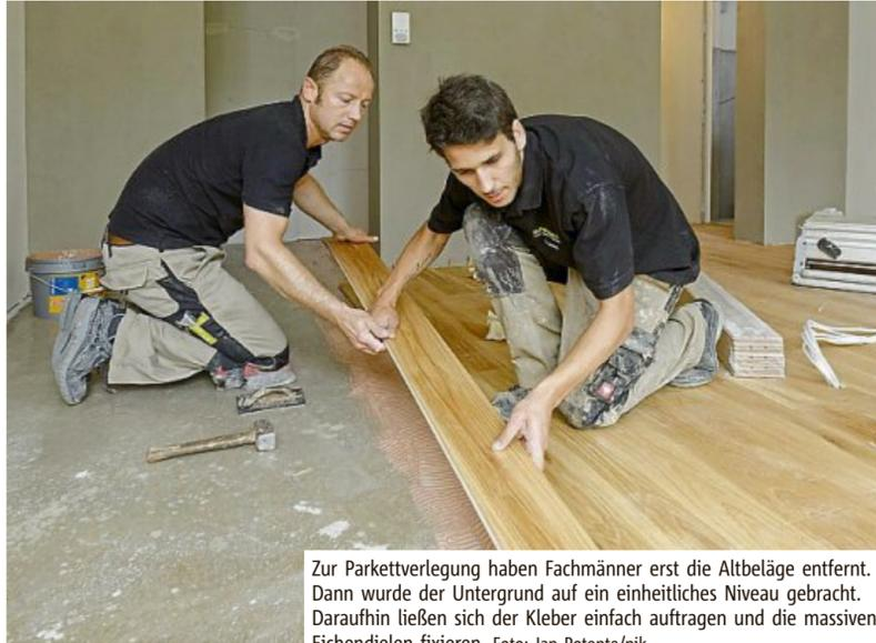
Zur Parkettverlegung haben Fachmänner erst die Altbeläge entfernt. Dann wurde der Untergrund auf ein einheitliches Niveau gebracht. Daraufhin ließen sich der Kleber einfach auftragen und die massiven Eichendielen fixieren. Foto: Jan Potente/pik
