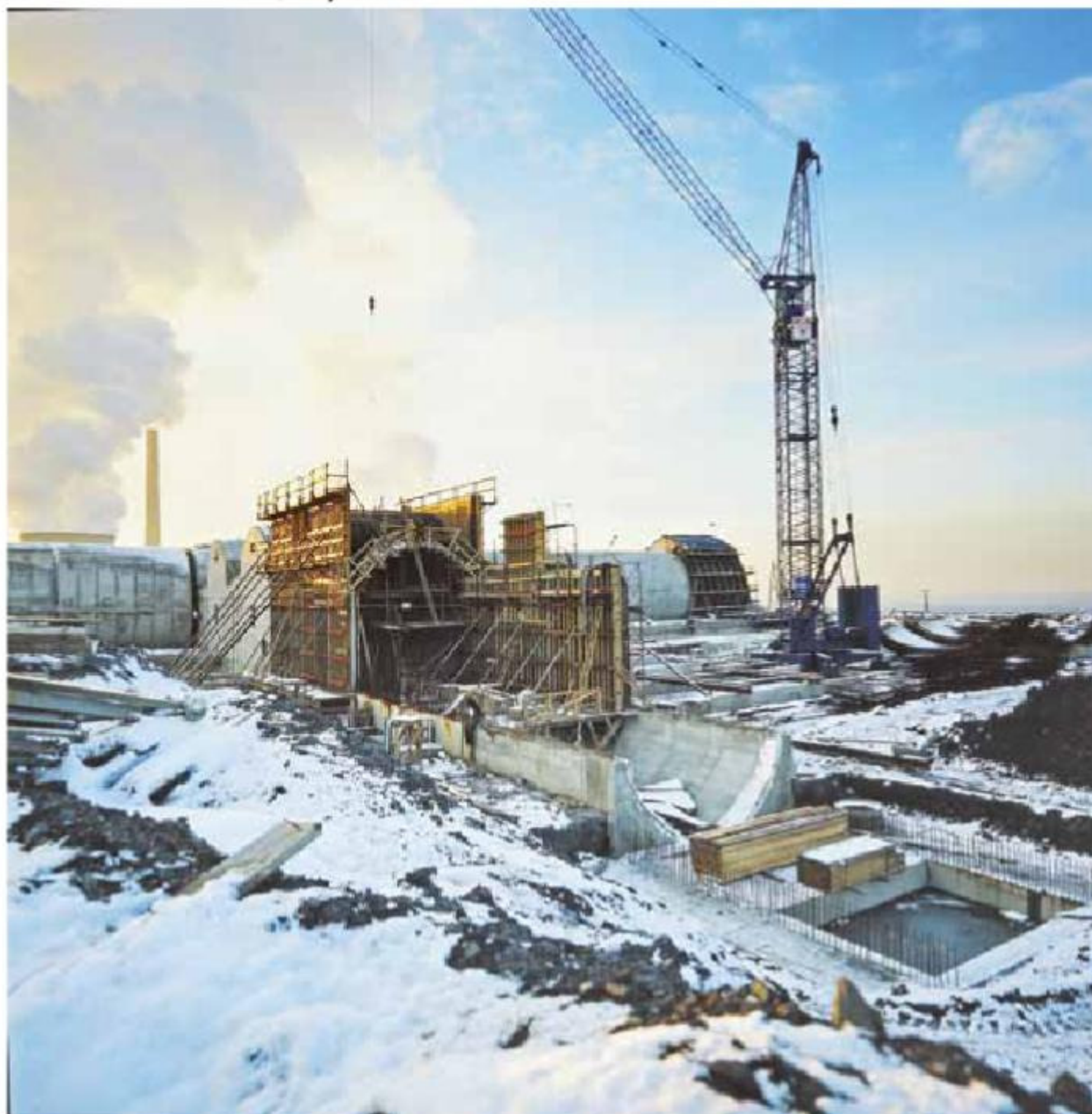
Bau des Wasserbehälters auf der Bergehalde Scholven mit einem Inhalt von 36.000 Kubikmetern, Frühjahr 1980
