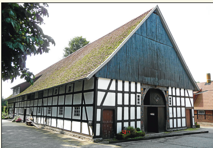
Hofgebäude des Sudhoff-Hofes vom 16. Juli 1765 (Foto: B. Kößmeier, 2014).
