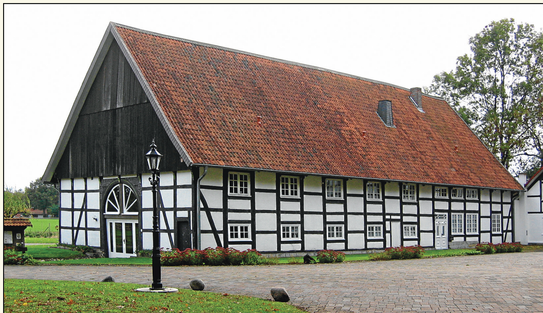
Hofgebäude des Almodt-Hofes vom 10. Juni 1711 (Foto: B. Kößmeier, 2014).
