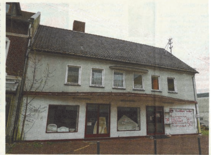
Das Gebäude an der Marburger Straße, in dem sich früher das Kino befand, wird bald abgerissen. Foto: STEFFEN SCHWAB
