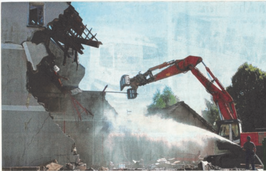
So ein Abriss ist ein ziemlicher Gewaltakt. Mit Wasser hält das Abrissunternehmen die Staubbildung in Grenzen - und sorgt für etwas Abkühlung in der Hitze. Foto: Jan Schäfer
