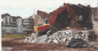
Am Mittwoch wurde mit den Abrissarbeiten des Doppelhauses begonnen. Der Bagger „fraß“ sich von hinten nach vorn.
