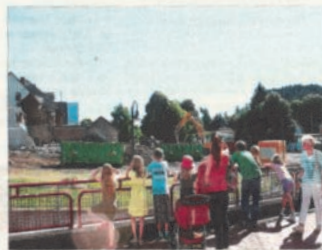
Viele Zuschauer gab es gestern, als der Abriss schon fortgeschritten war. Für das nötige Publikum sorgte der Wochenmarkt.
