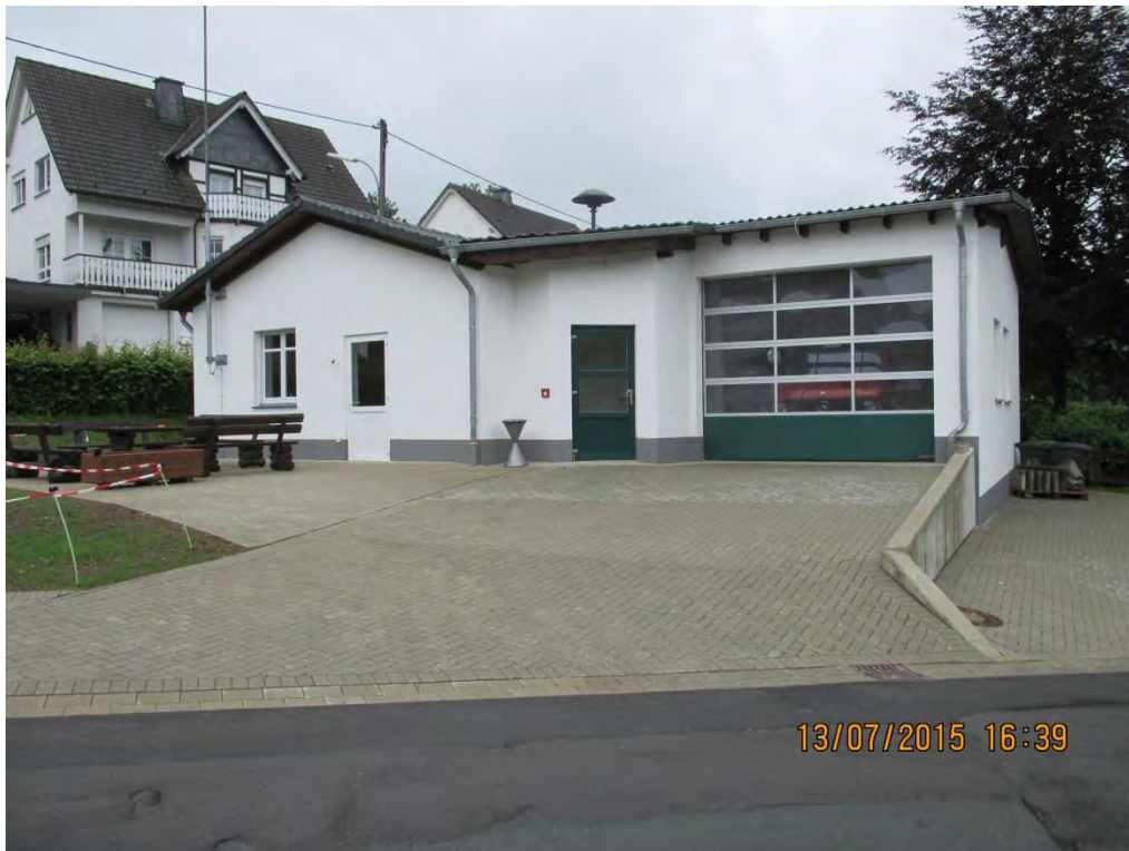
Feuerwehrgerätehaus Schliprüthen nach Durchführung der Erweiterungs- und Umbaumaßnahme
