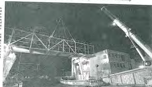
In der Nacht zum Sonntag wurde das erste von insgesamt vier Segmenten der neuen Fußgängerbrücke, die zukünftig die Gleisanlagen und die Landstraße L 539n überbrücken wird, am Bahnhof Finnentrop eingebaut.
