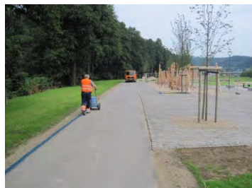
Mitarbeiter des Bauhofes der Stadt Lennestadt bei der Markierung des Blauen Bandes im Lennepark Finnentrop
