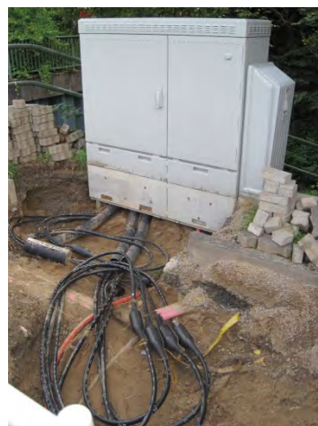
Verlegung und Anschluss der Glasfaserkabel
