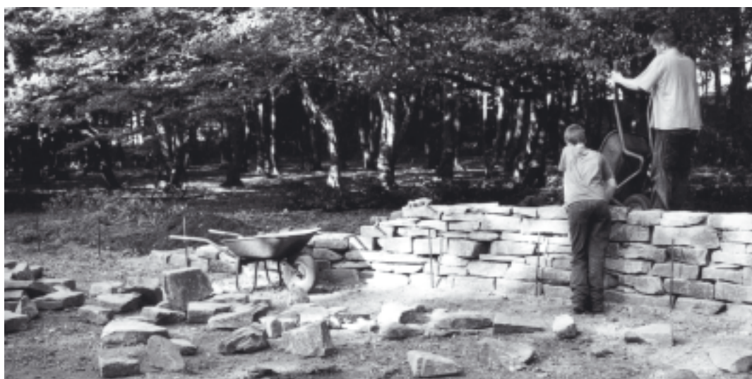
Anlegen einer Trockenmauer. Foto: W. Siemen
