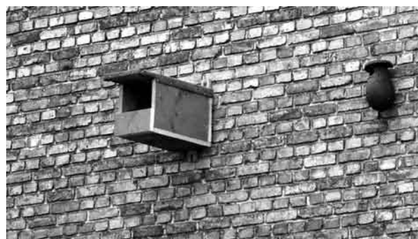
Turmfalkenkasten, montiert an der Giebelwand eines Gebäudes.
